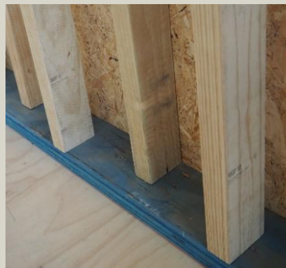
Staggered stud wall frame
