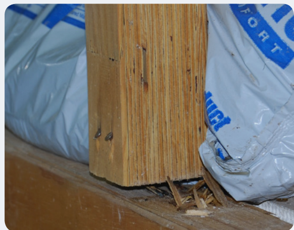
(d) Strut-to-top-plate connection
